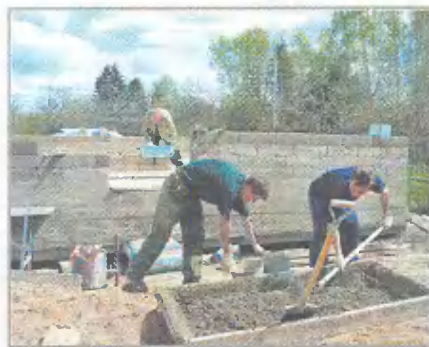
Раствор для формирования блоков мы замешивали на бойке
