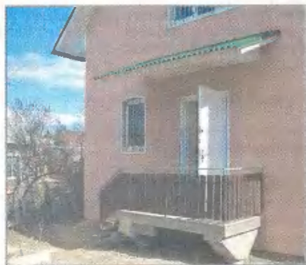
Крыльцо опирается на 2 опоры
