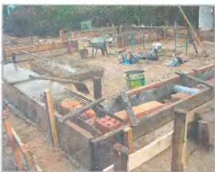
Для экономии материалов, сил и времени при заливке ростверка использовали в качестве заполнителя старые кирпичи
