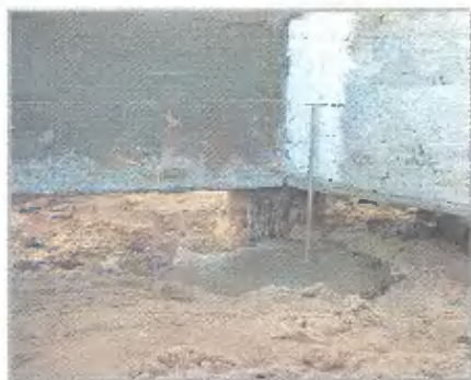
Для контроля подъема грунта из-за пучения я зафиксировал штырь арматуры в «бетонной лепешке»
