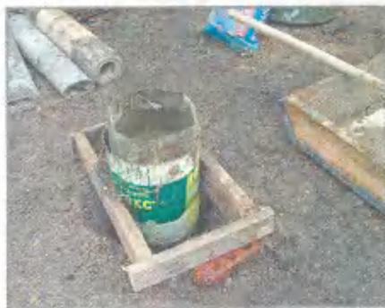
Приспособление для заливки бетона в скважину
