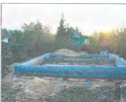
Готовый фундамент с двумя рядами стеновых блоков
