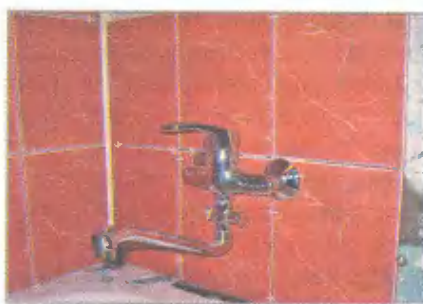
Смеситель для ванны оставил старый (он прослужил всего два года). Заменил только гибкий шланг и лейку
