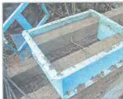
Формирование на стене блока без бетонных перемычек
