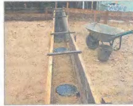
Опалубка для заливки ростверка
