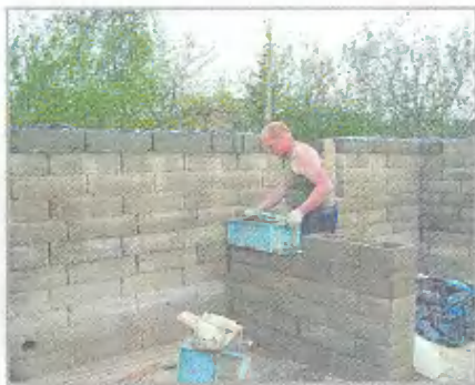
Формирование внутренней стены дома
