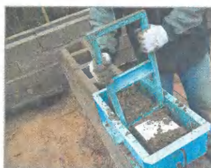
Работа со съемной опалубкой ТИСЭ
