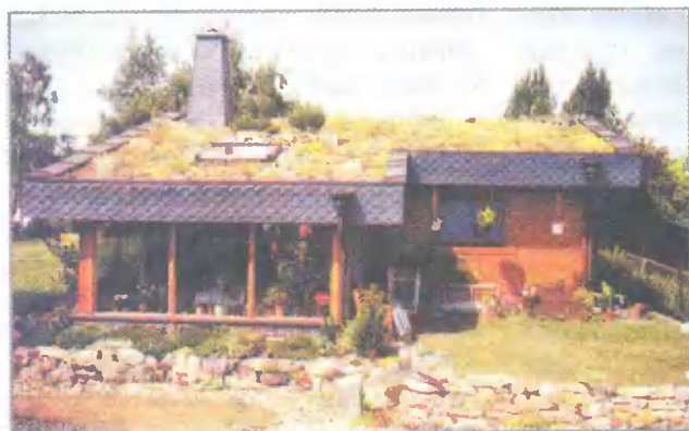
Живая зелень на крыше дома «Natura Flora» — альтернатива черепичной кровле. Специальные растения с весны до зимы создают на его крыше целую палитру цветов
