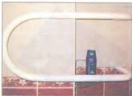
Полотенцесушитель заменять не стал — покрыл его белой краской, предназначенной для горячих труб и радиаторов отопления. Он вполне гармонирует с оборудованием ванной комнаты
