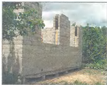
Оконные проемы по краям закрыты досками
