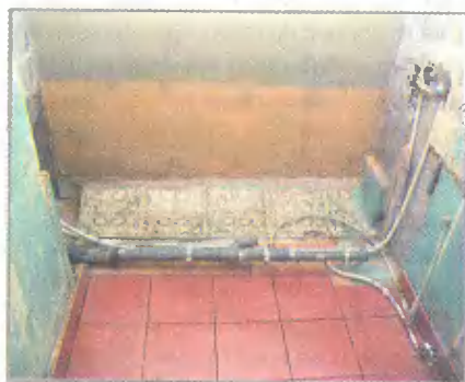
Общая площадь пола ванной комнаты — около 2,5 м². Часть пола под ванной я выложил плиткой, оставшейся после ремонта туалета и других «перестроек». Это позволило обойтись двумя упаковками плитки (1 упаковка ~ 1 м²).
